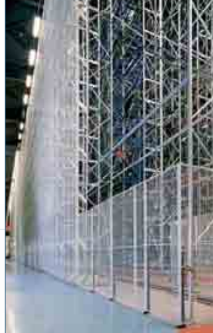
Cerramientos de seguridad y anticaídas
