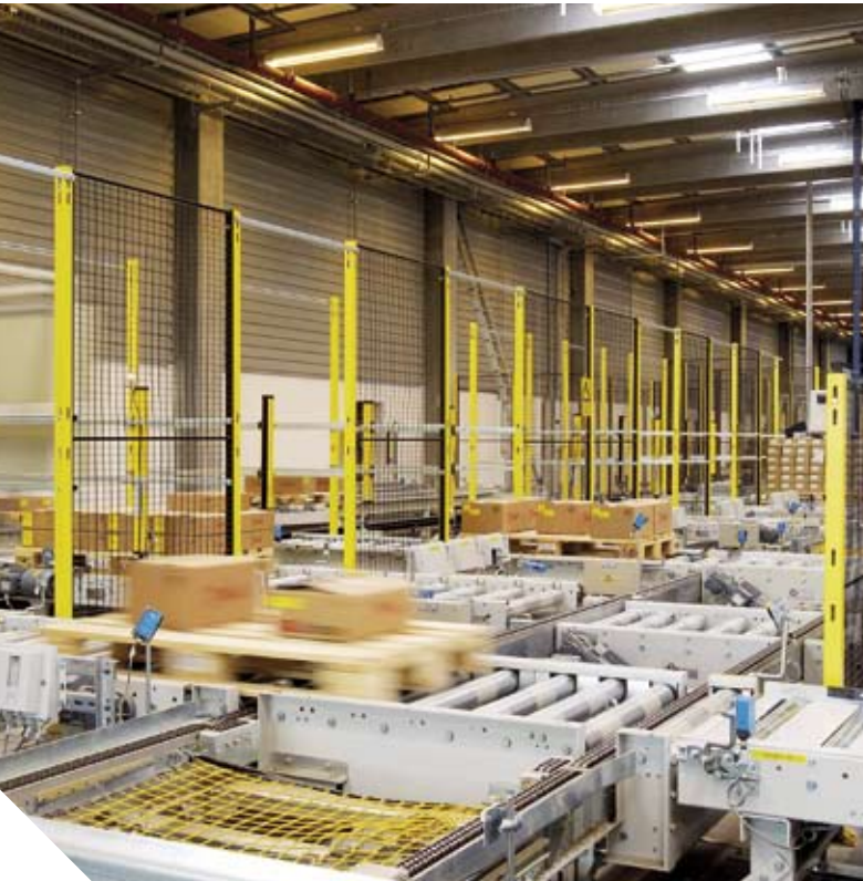
FlexiGuard alrededor de una cinta transportadora de Danfoss A/S, Dinamarca. La instalación ha sido realizada por T.U.Langebaek de Gebhardt.
